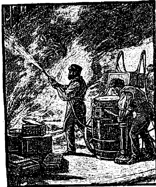
NOUVELLE POMPE A INCENDIE.
