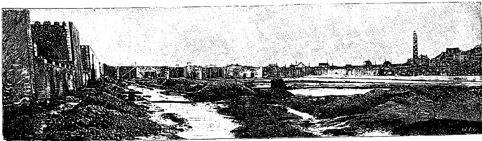
2. CALAIS. — Travaux du nouveau port.
