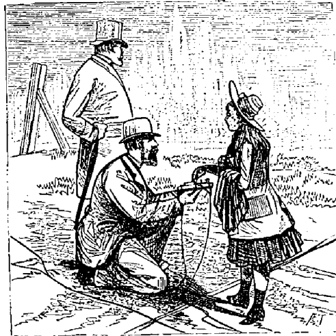
LES EXPLOSIFS. - L'explosion de Flood-Rock. - Feu! (Page 195, col. 1.)
