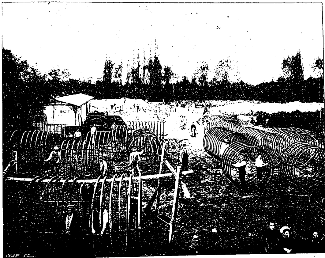
L'ASSAINISSEMENT DE PARIS. — Montage des armatures métalliques destinées aux conduites en ciment armé du siphon de Chennevières.
