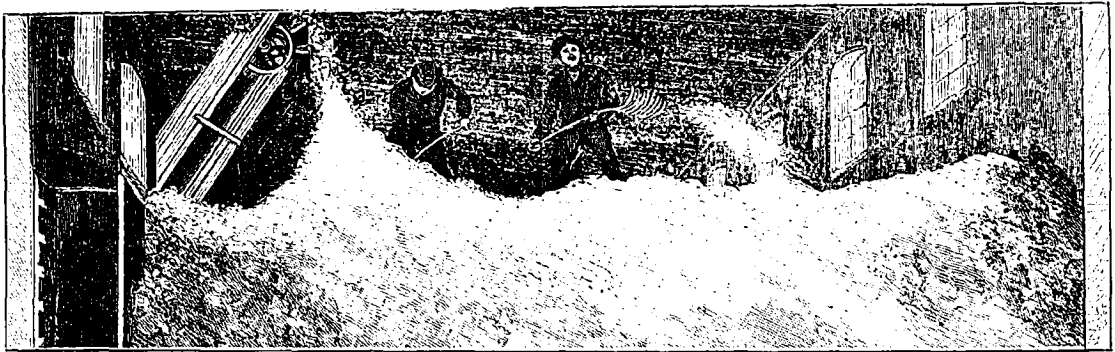
LA FABRICATION DU PAPIER. — Magasin à copeaux, situé au-dessus des digesteurs.
