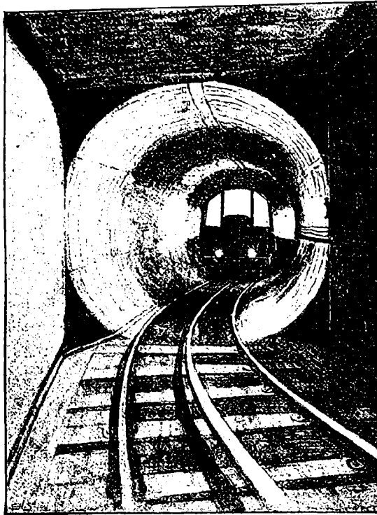
LE SECOND CHEMIN DE FER ÉLECTRIQUE DE LONDRES. Entrée de l'un des tunnels métalliques.
