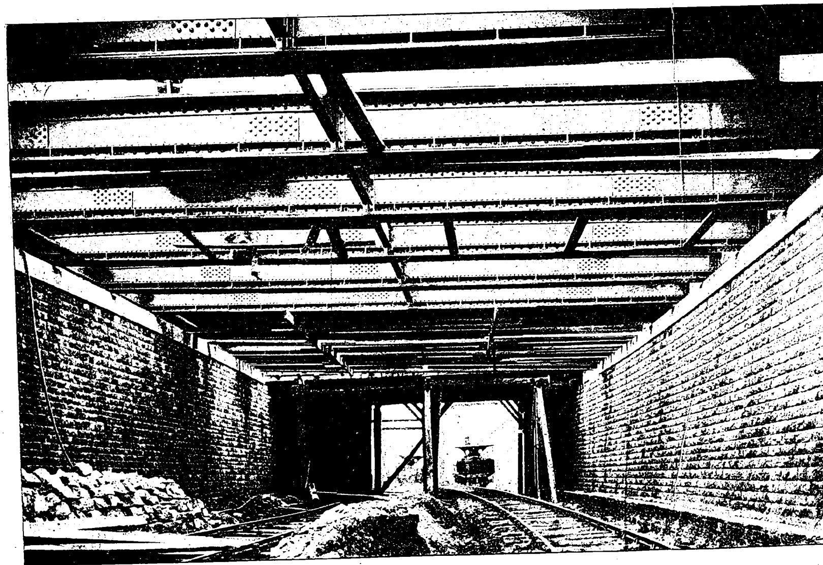
LE PROLONGEMENT DE LA LIGNE DES MOULINEAUX. — Tunnel en construction sous le quai d'Orsay.
