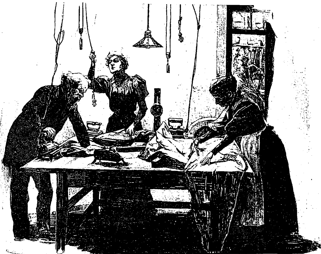
LES FERS À REPASSER ÉLECTRIQUES. — Installation d'un atelier d'apprêteur pour costumes de théâtre.
