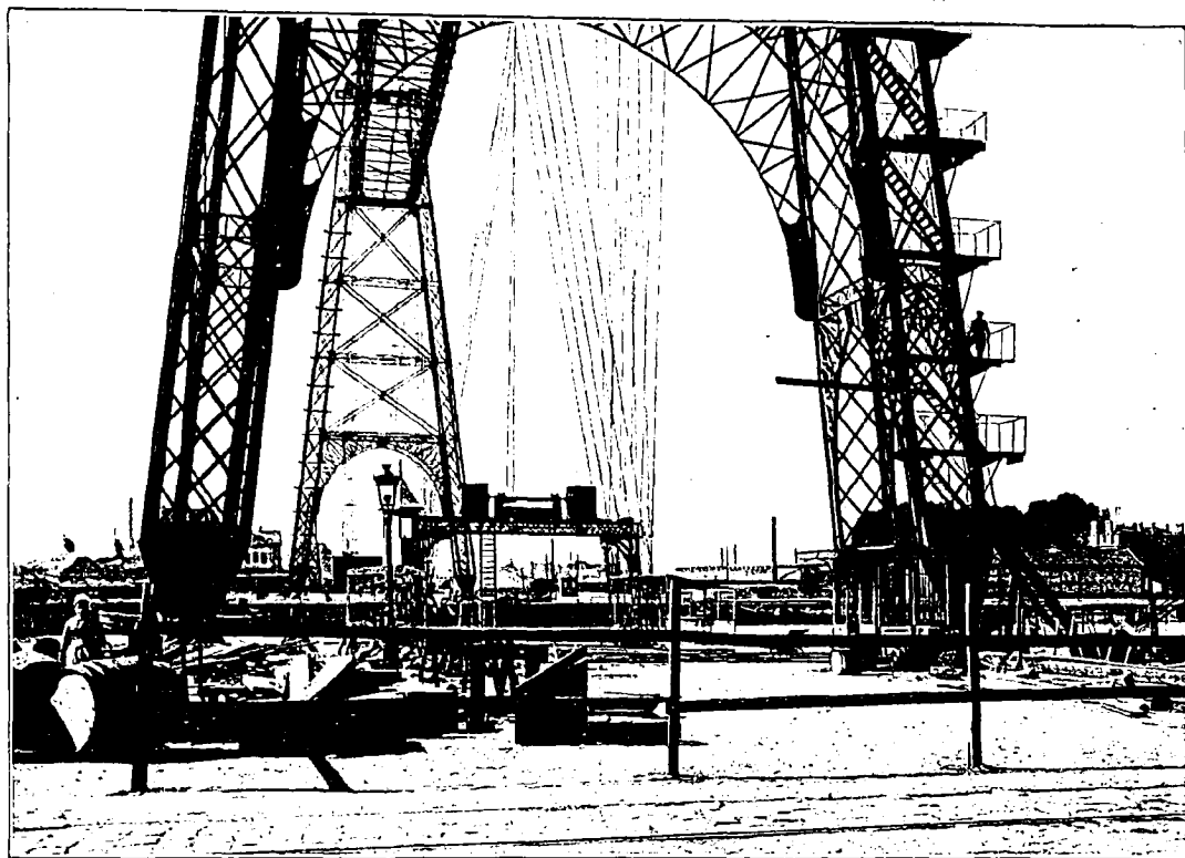
LE TRANSBORDEUR F. ARNODIN, A ROUEN. — Vue prise dans l'axe longitudinal.
