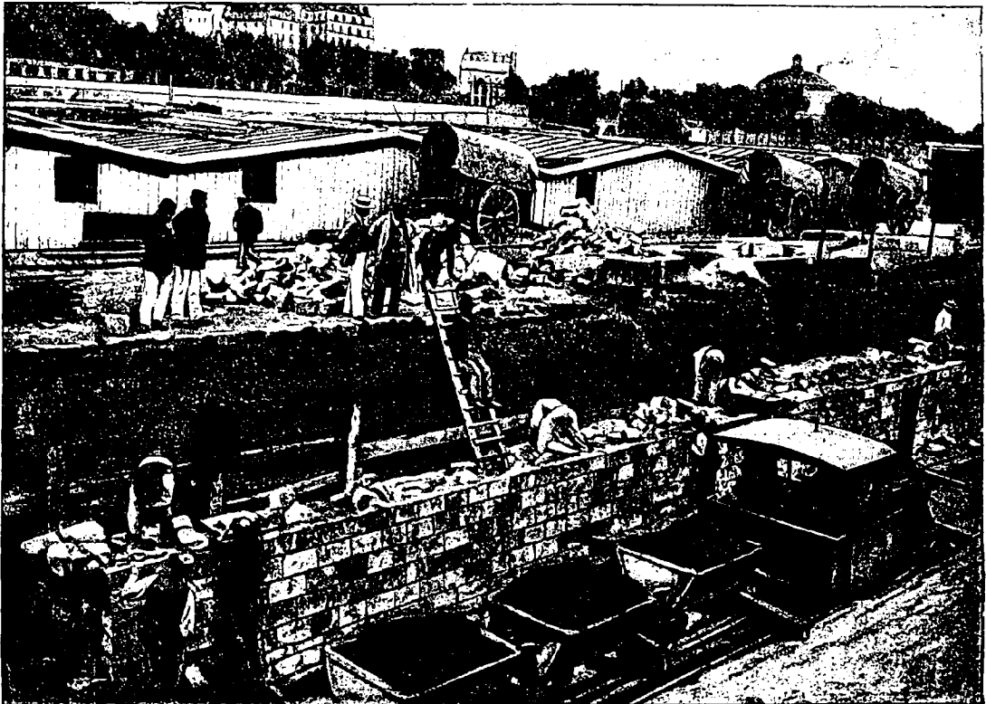
LE PROLONGEMENT DES LIGNES DE LA COMPAGNIE D'ORLÉANS. 1. Chantier pour le dépôt du matériel. — 2. Construction du mur de tranchée, au quai Saint-Bernard.
