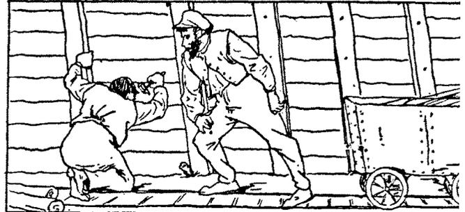
22. On prévient les éboulements en soutenant par des *charpentes* ou *étais* les parois et le plafond des galeries. C'est ce qu'on nomme le *boisage*.
