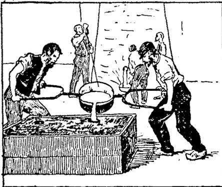
11. Les deux châssis remis en place, on verse de la *fonte*\* dans l'espace laissé vide par l'enlèvement du modèle en bois.
