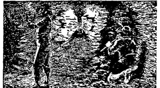
24. On peut les éviter ces explosions en n'enflammant jamais d'allumettes dans les galeries et en ne se servant que de *lampe de sûreté* (p. 34, fig. 35).
