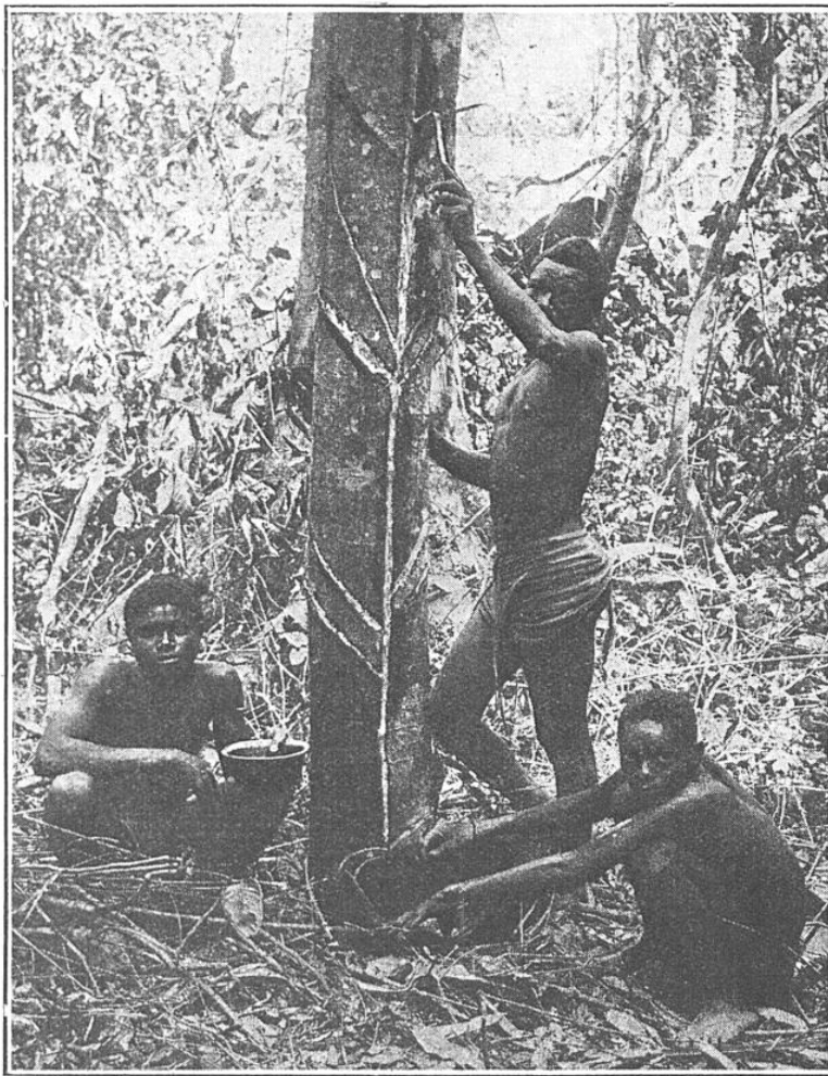
LA RÉCOLTE DU LATEX D'UN « FUNTUMIA ELASTICA » INCISÉ EN « ARÊTE DE POISSON »
