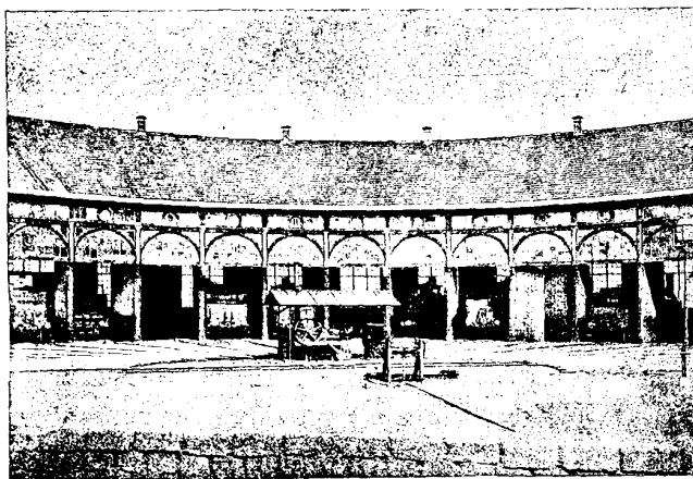
Fig. 1. — Remise à locomotives demi-circulaire.
