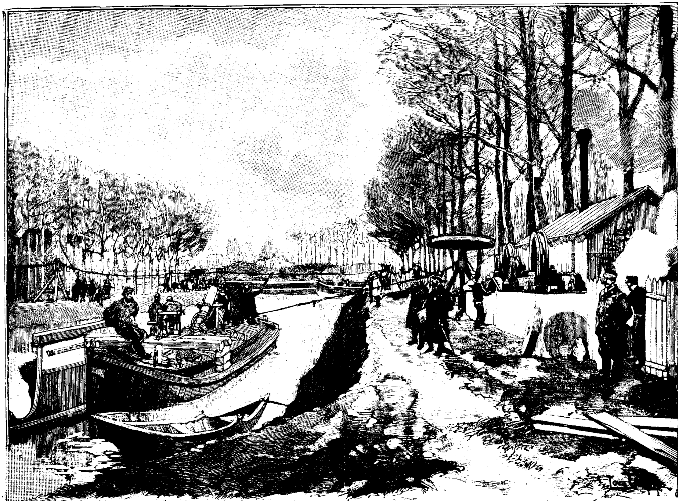
TRACTION DES BATEAUX PAR CABLE. — Installation du câble, jonction des canaux de Saint-Maur et Saint-Maurice. Les expériences en présence du ministre des Travaux publics, à Joinville-le-Pont (p. 97-98).
