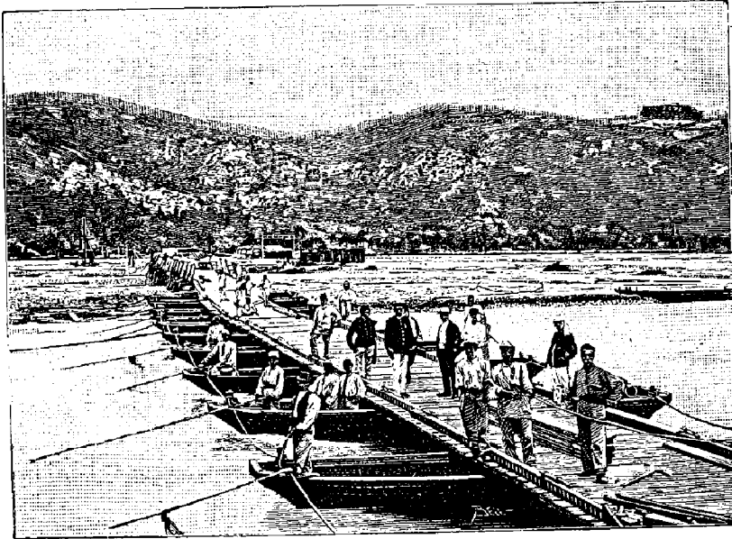
LE PONT DU VAR. — Les travaux sur la rive droite.
