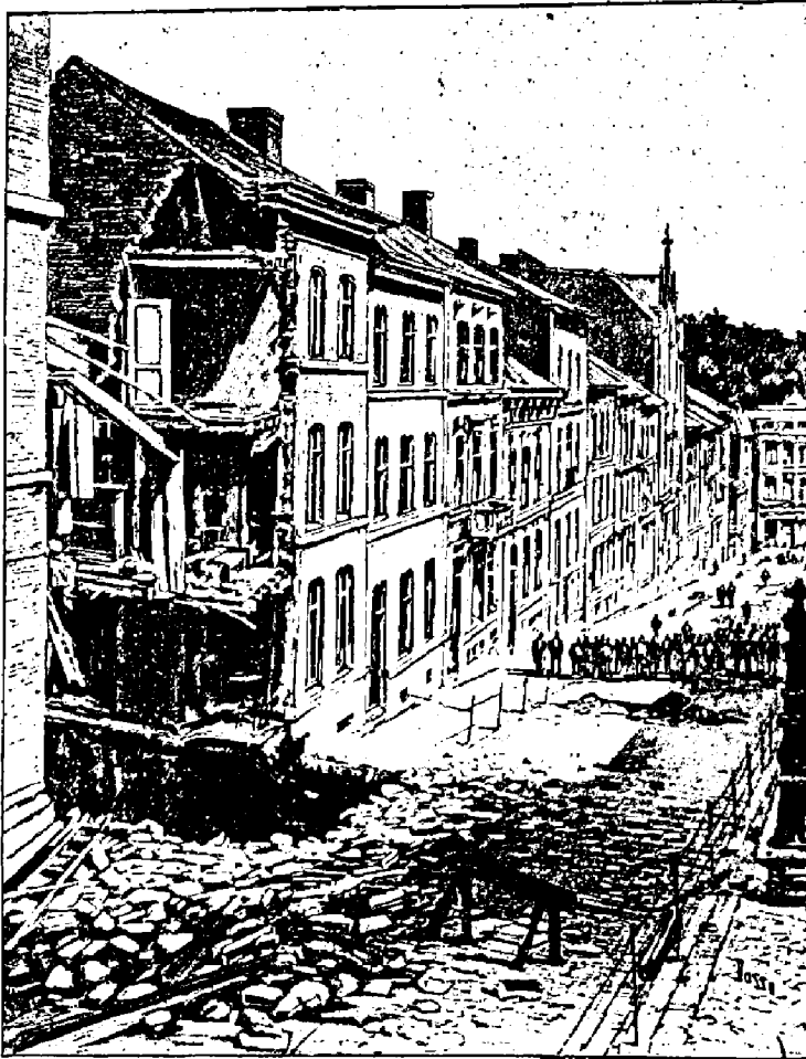
UN AFFAISSEMENT DE TERRAIN. — Écroulement d'une maison à Liège.
