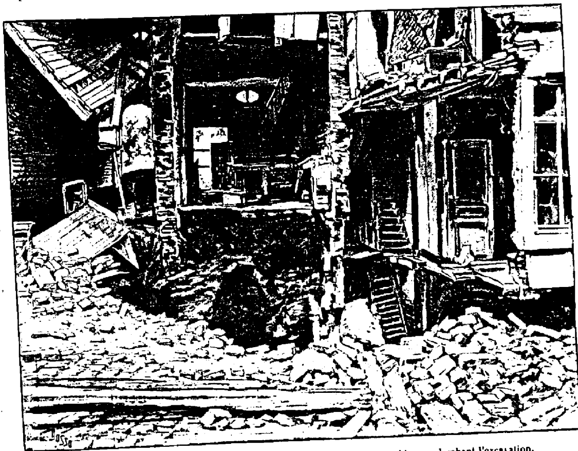
UN AFFAISSEMENT DE TERRAIN. — Partie de la maison écroulée surplombant l'excavation.
