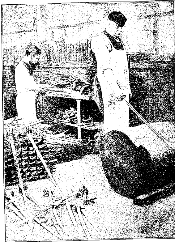
LA MANUFACTURE D'ARMES DE SPARKBROOK. Essai des lames de sabre sur un billoï de bois dur.
