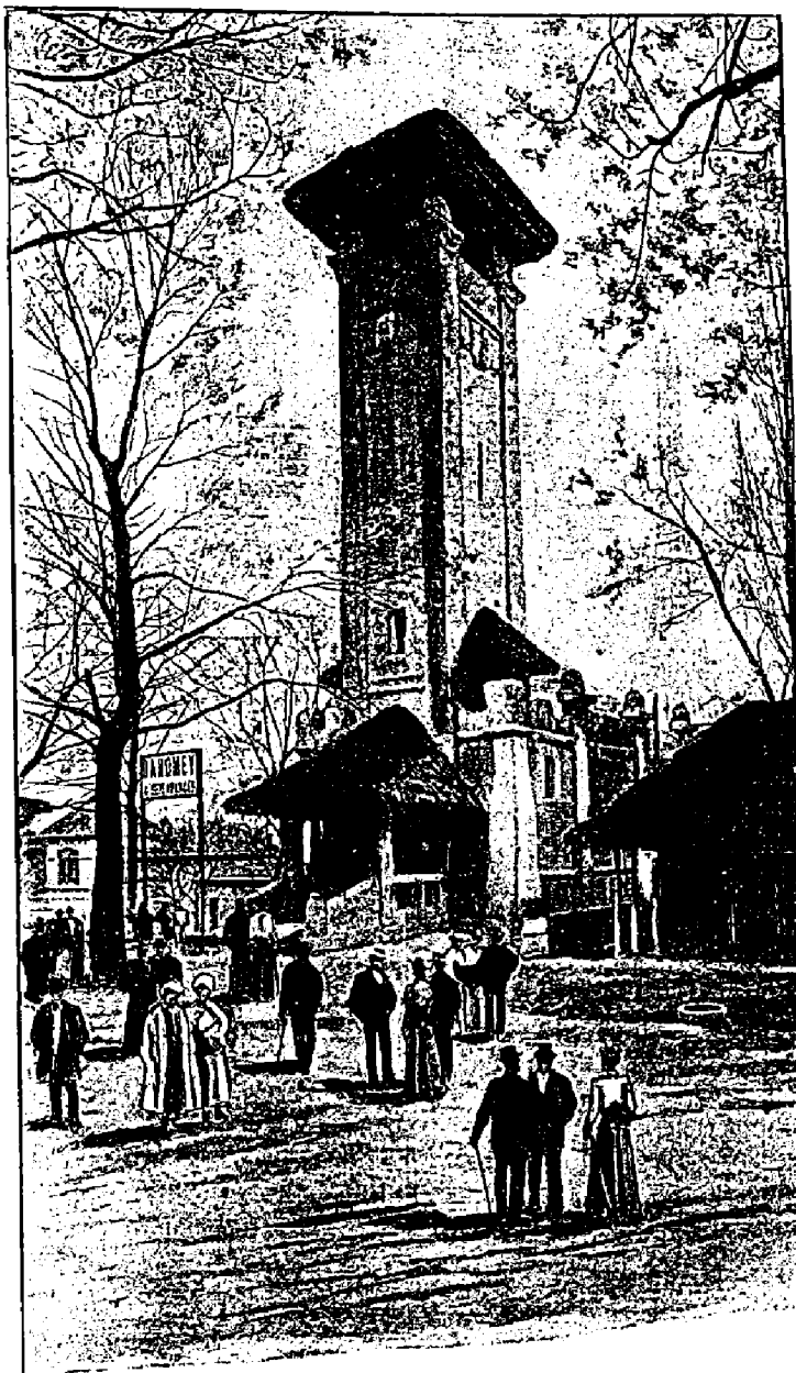
LE PAVILLON DU DAHOMEY. — Porche et tour d'entrée.
