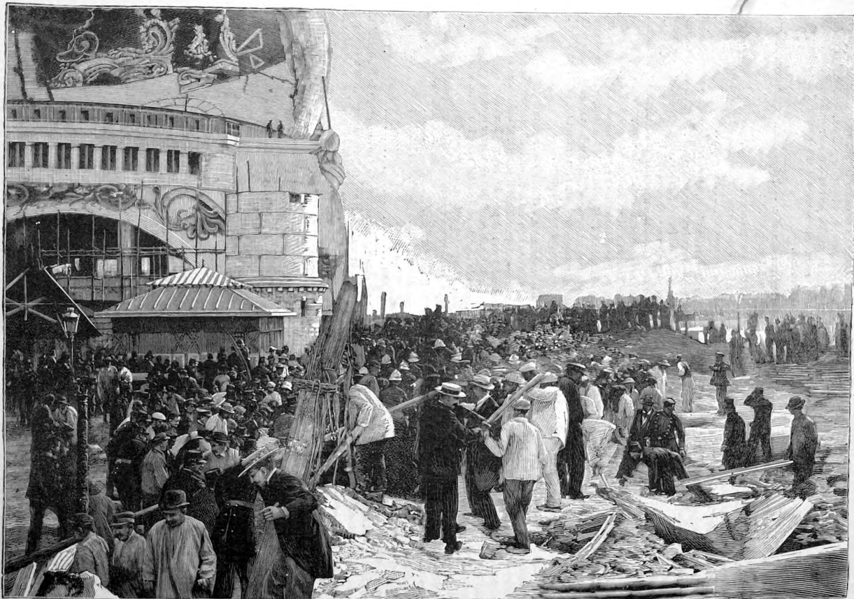
LA PASSERELLE DU GLOBE CÉLESTE. — Après la catastrophe.
