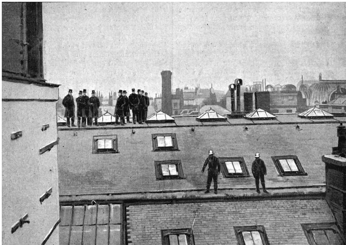
L'INCENDIE DU THÉÂTRE-FRANÇAIS. — Les premières constatations sur la coupole du théâtre.
