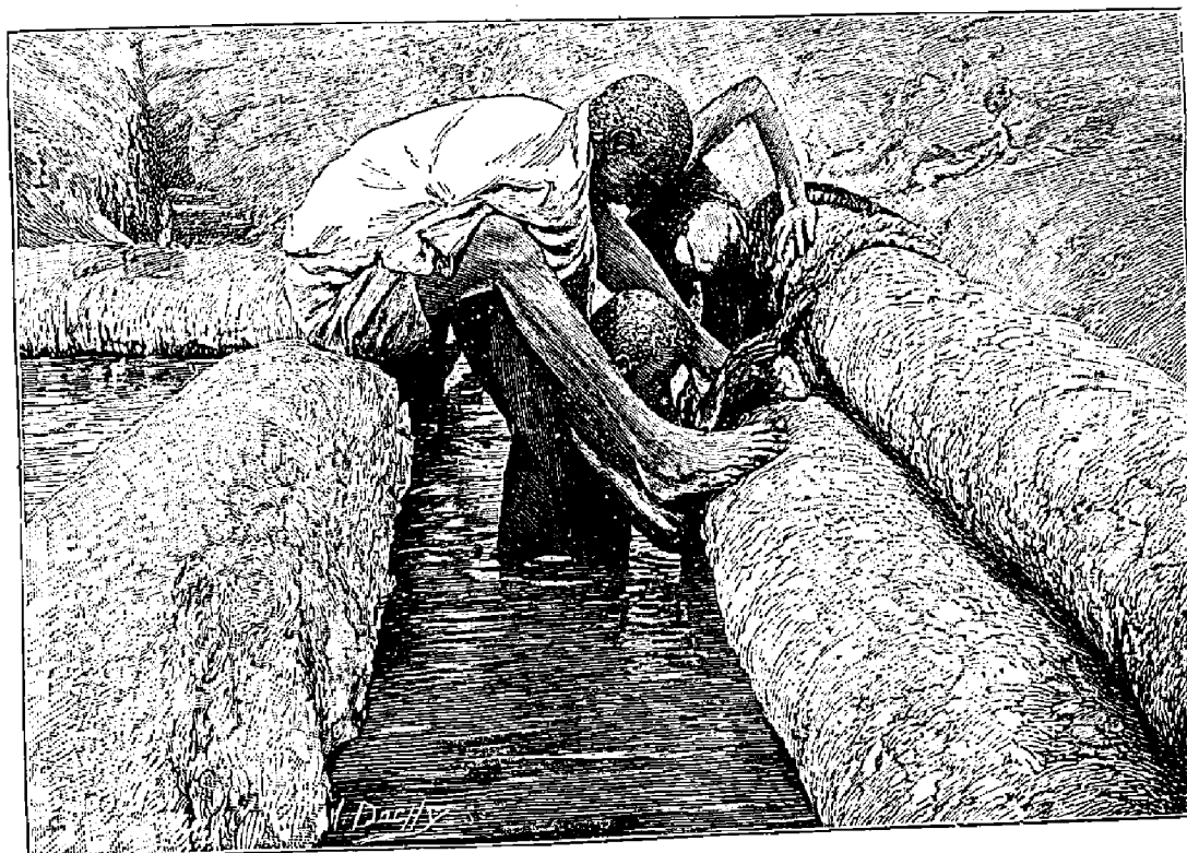
LES PUIES ARTÉSIENS DANS LE SAHARA. — Plongeur r'assin revenant de débayer l'œil d'un puits.
