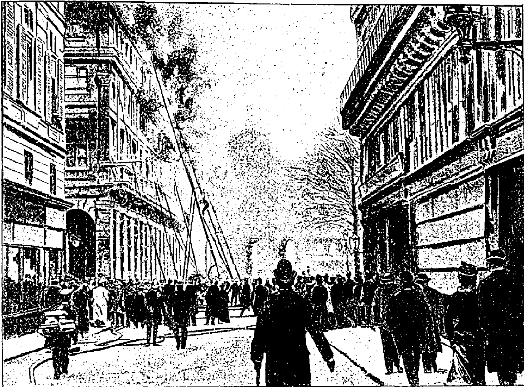
L'INCENDIE DU THÉÂTRE-FRANÇAIS. — Aspect de la façade à une heure de l'après-midi, le 8 mars 1900.
