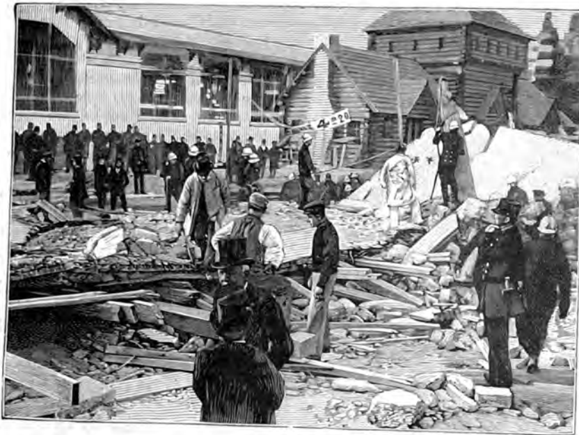
LA PASSERELLE DU GLOBE CÉLESTE. — Les travaux de déblaiement.
