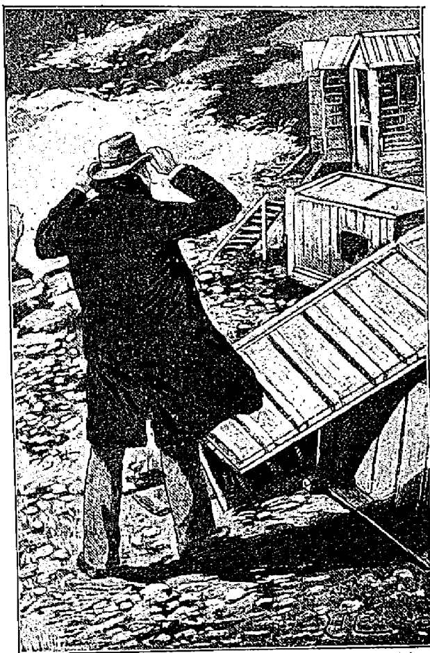
L'EAU DE JOUVENCE. — En revenant sur ses pas, il faillit être atteint par la chute d'une cabine dont la toiture vint rouler jusqu'à ses pieds.
