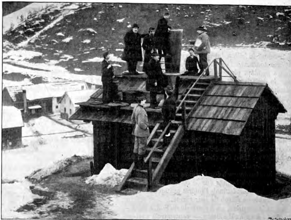
LA MÉTÉOROLOGIE A COUPS DE CANON. — Tir vertical d'un mortier paragrèle.
