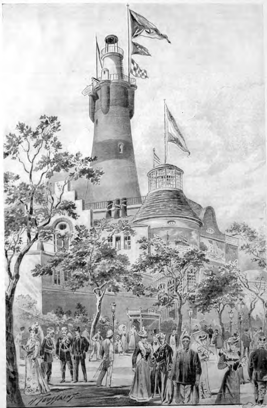
ANNEXE DE LA NAVIGATION COMMERCIALE (ANNEXE DE L'EMPIRE D'ALLEMAGNE). — Façade principale.
