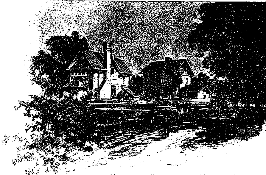
L'ANNEXE DE VINCENNES. — Maisons ouvrières.
