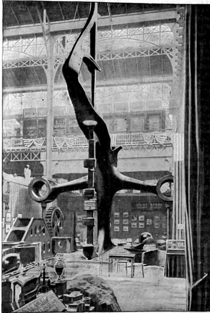
L'EXPOSITION DES MINES ET DE LA MÉTALLURGIE. — Étambot de navire, en acier coulé.
