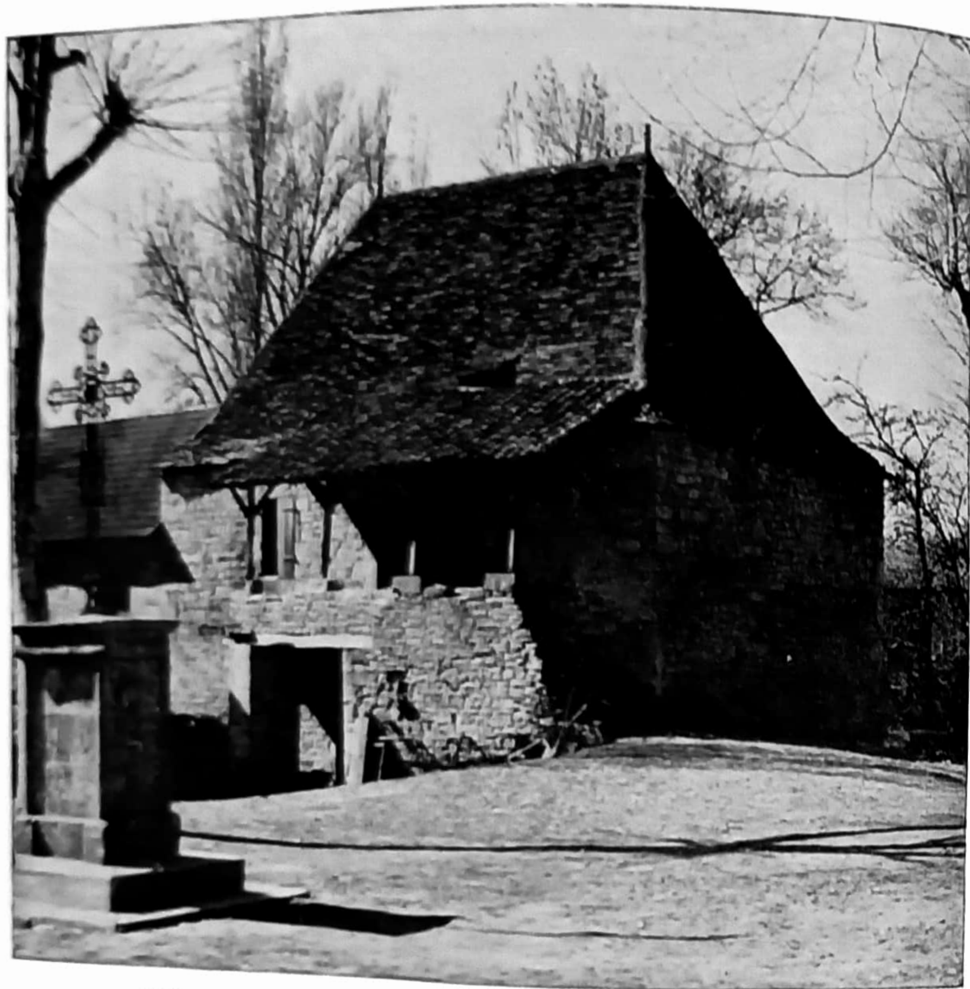
TOIT CELTIQUE AVEC BOLET DE TUILES-CANAL A GIGOUZAC
