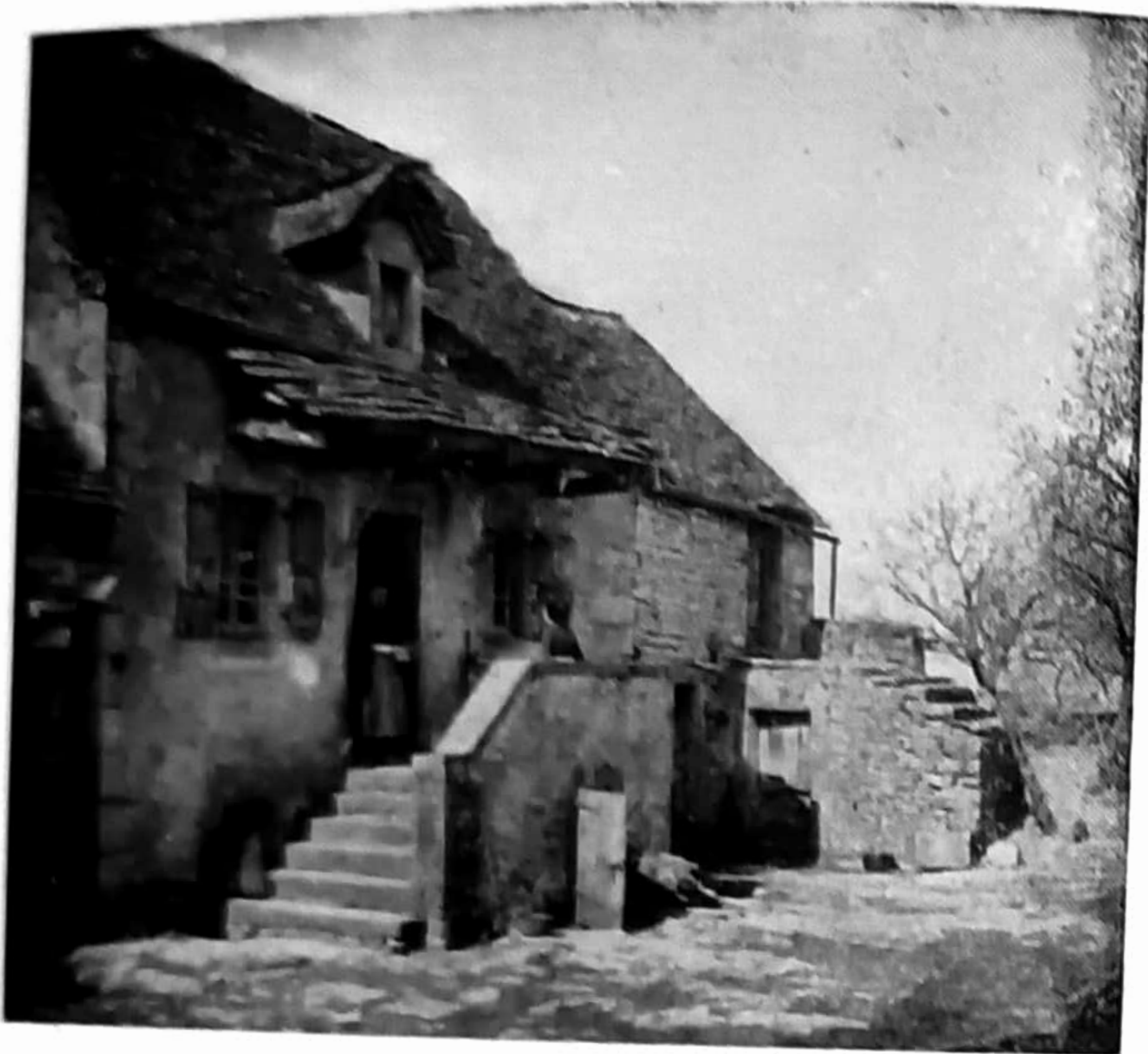
TOIT DE PIERRE A ST-JEAN-DE-LAUR AVEC AUVENT DE PIERRE SUR L'ESCALIER EXTÉRIEUR
