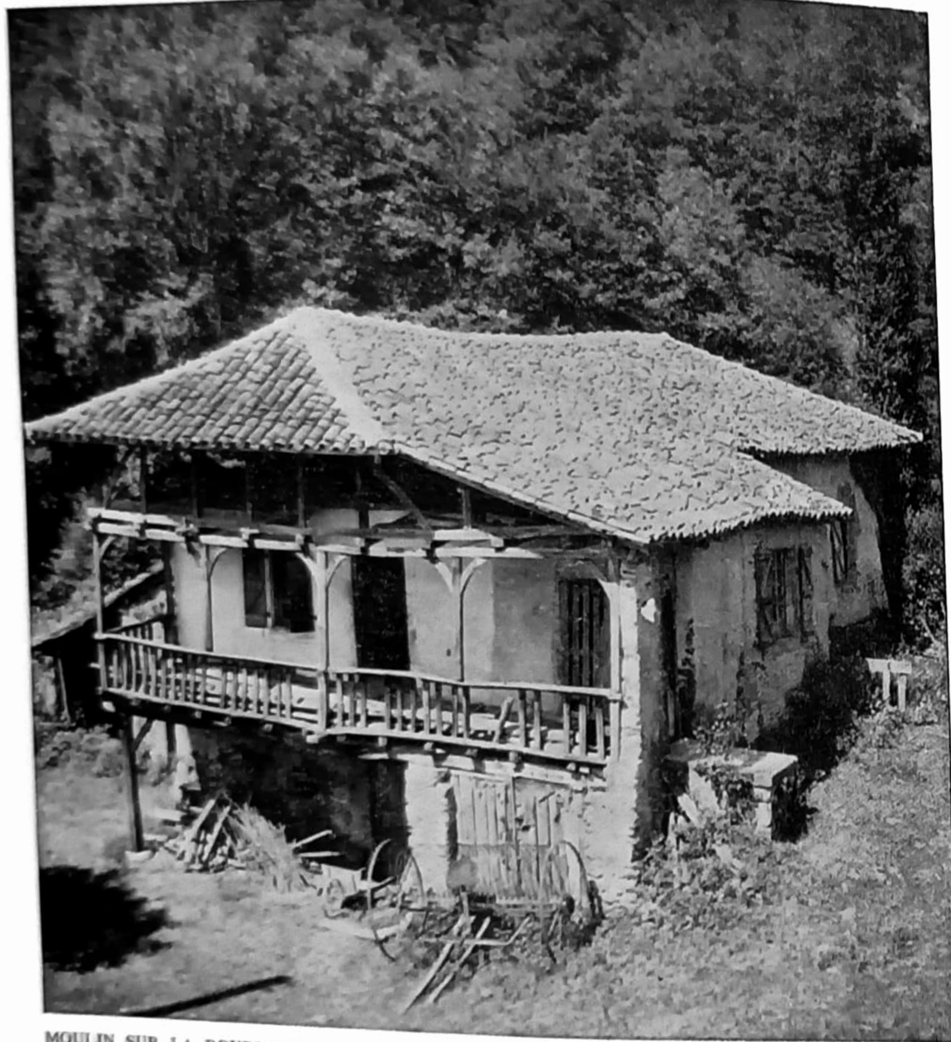
MOULIN SUR LA BOURLANDE A LINAC - GALERIE CHARPENTÉE ET TOIT MÉDITERRANÉEN RÉGION DE FIGEAC
