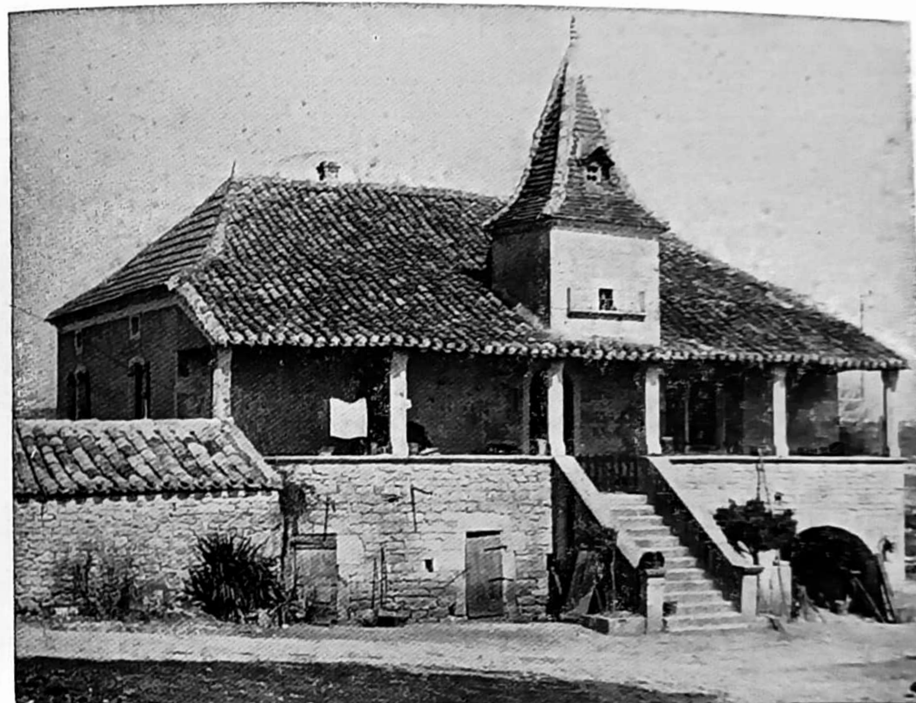
LARGE GALERIE ET PIGEONNIER-BOLET - TOIT MÉDITERRANÉEN A TRÉBAÏX (COMMUNE DE VILLESÈQUE) DATÉE DE 1863
