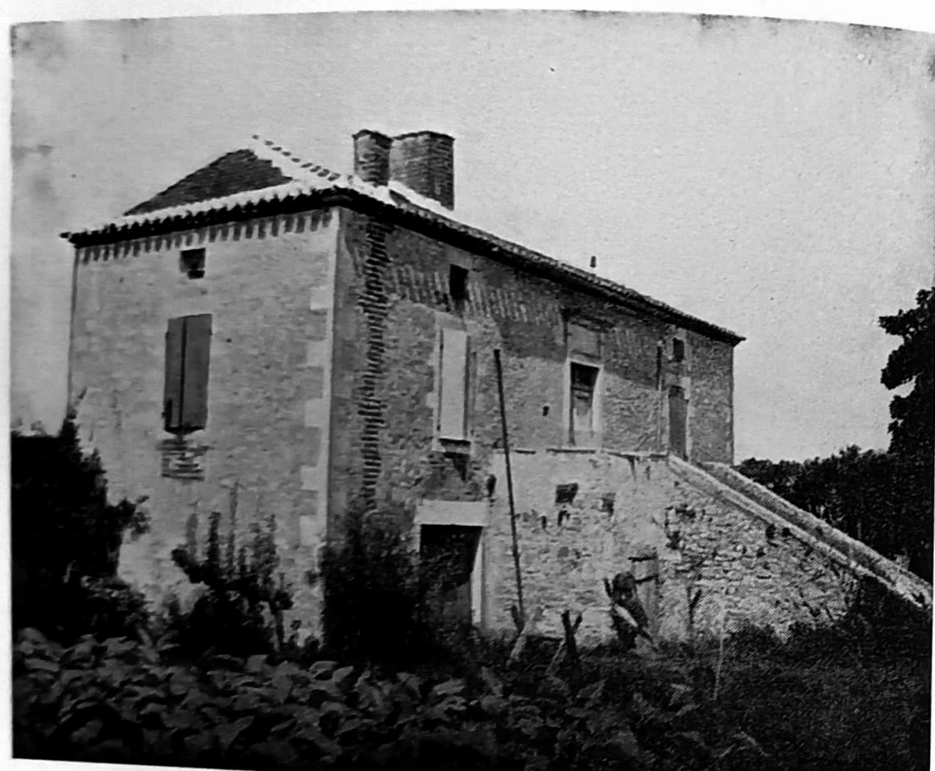
MAISON A SUPERPOSITION DANS LA VALLÉE DU LOT A JUILLAC TOIT MÉDITERRANÉEN - GRAND ESCALIER EXTÉRIEUR (DÉMOLI DEPUIS)
