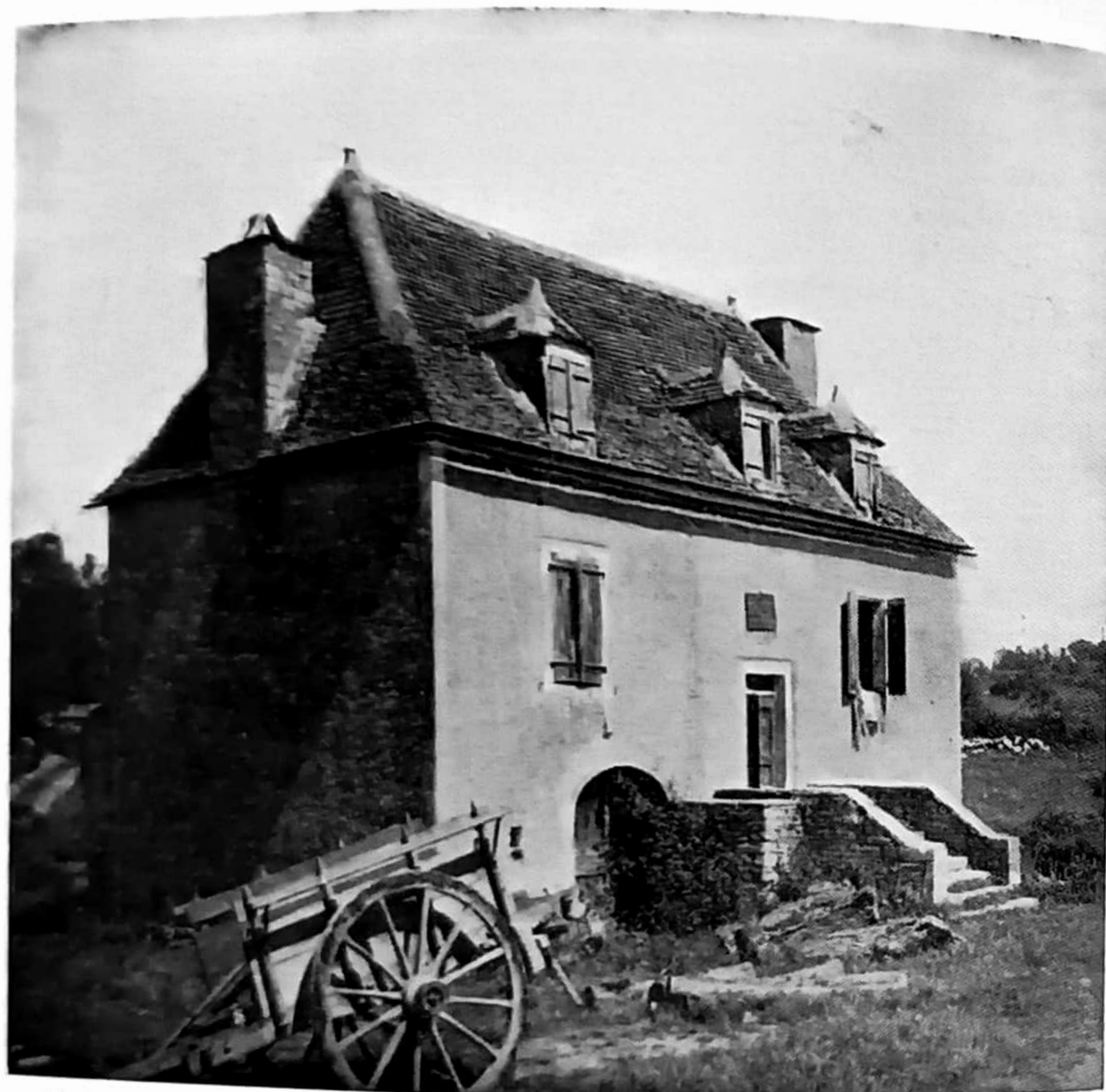
MAISON A SUPERPOSITION DU CAUSSE - TOIT MIXTE : TUILLES PLATES ET PIERRES DATÉE DE 1848 - SIFFRAY, COMMUNE DE CATUS
