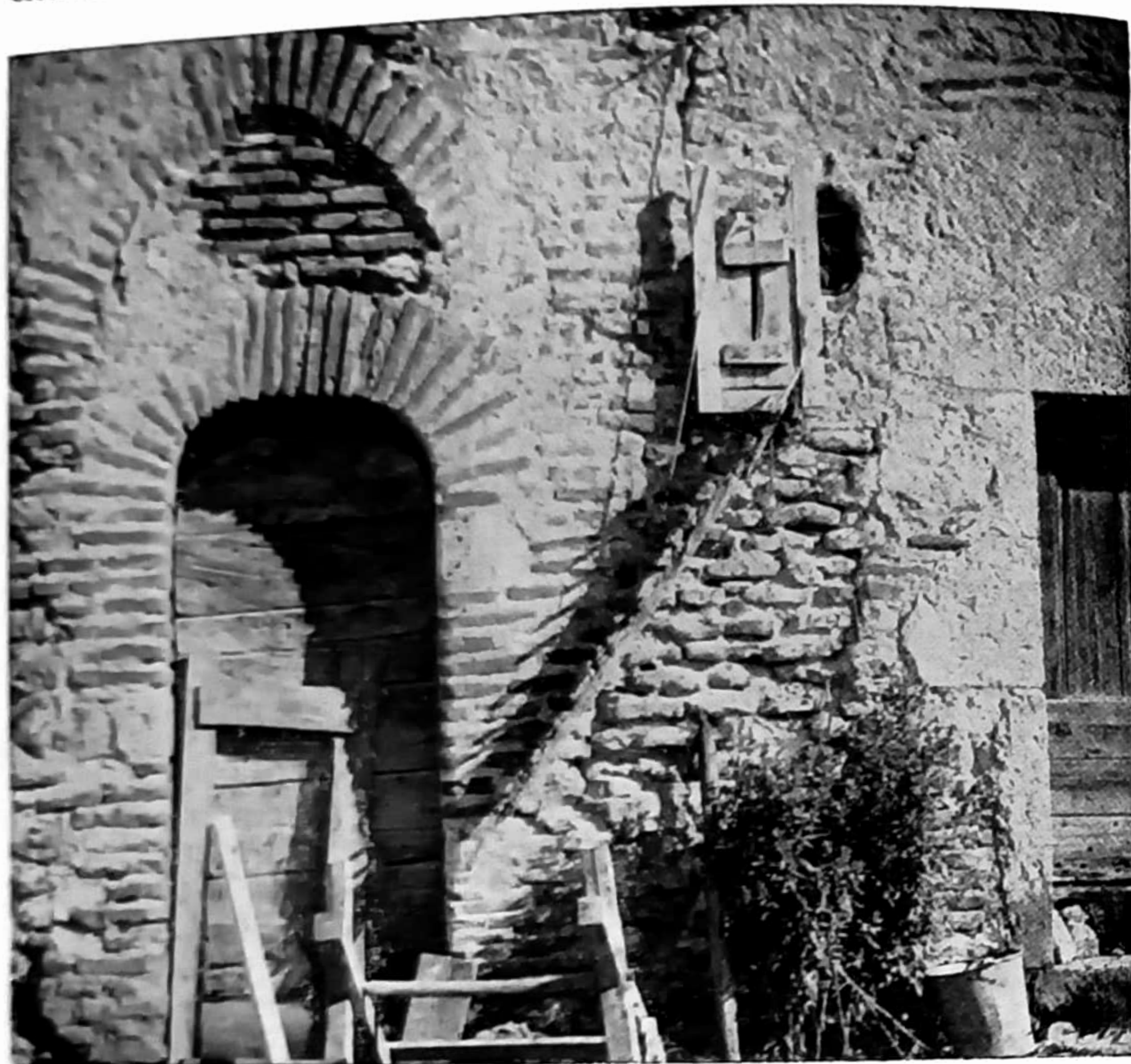
L'USAGE DE LA BRIQUE EST RARE. MAIS ICI BRIQUES PLATES ANCIENNES A SAVANAC (COMMUNE DE LAMAGDELAINE AU BORD DU LOT)
