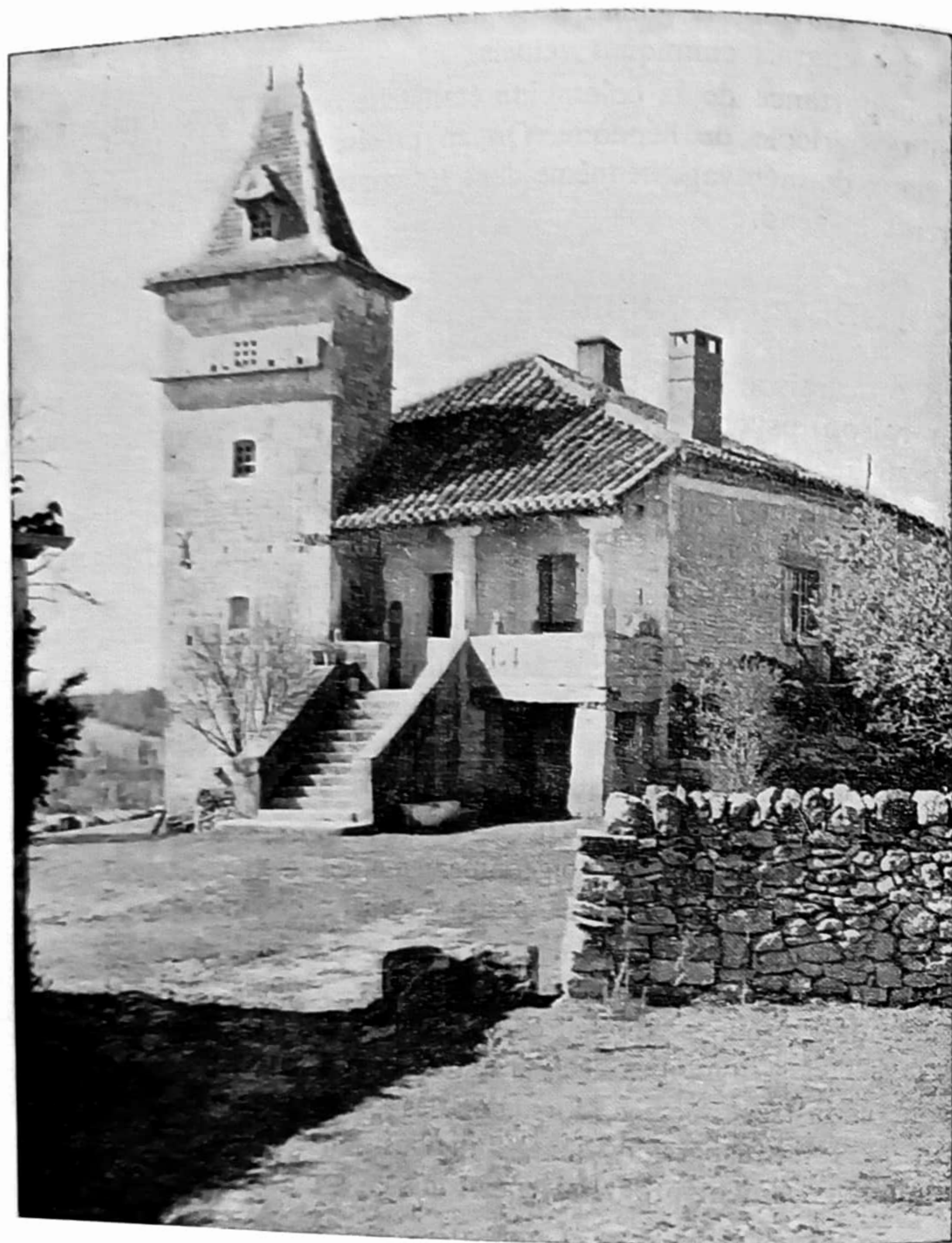
ESCAZA A FONTANES-LALBENQUE - GRAND PIGEONNIER-TOURELLE TOIT MÉDITERRANÉEN CONTINUÉ PAR LE TOIT DU BOLET PIERRE DOUCE DE CIEURAC
