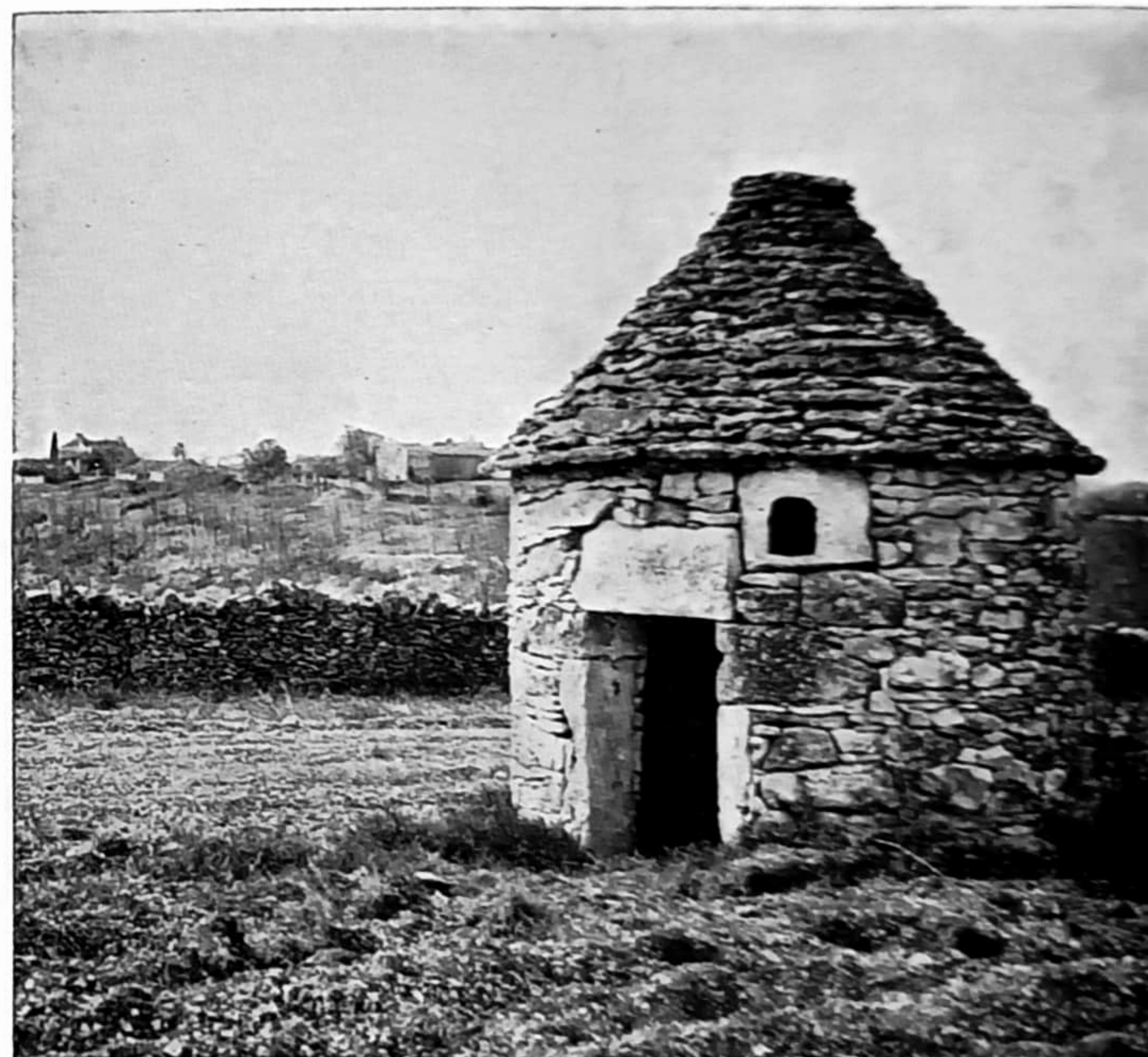
CABANE DE PIERRE A ESCLAUZELS - LINTEAU MONOLITHE
