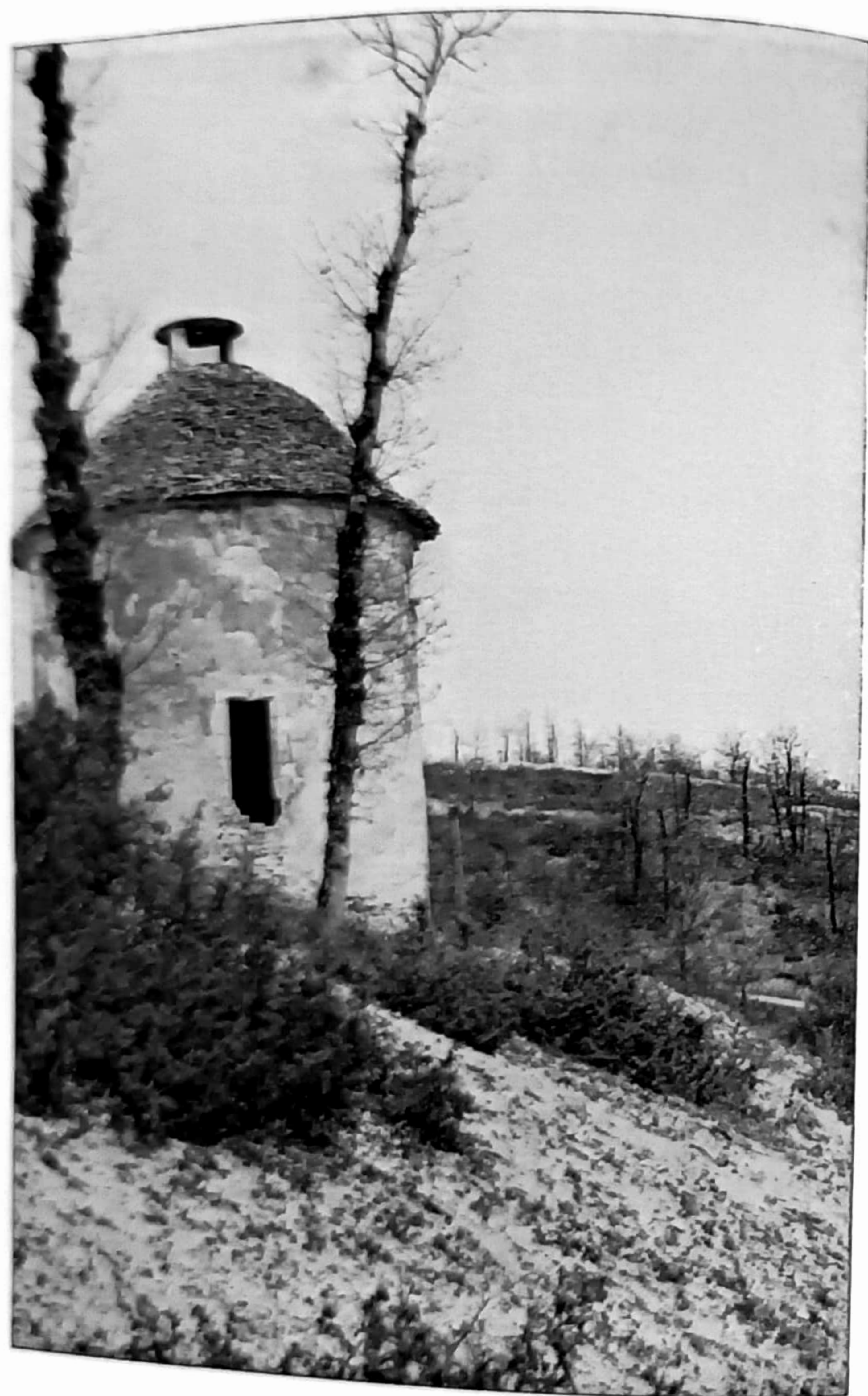
PIGEONNIER CYLINDRIQUE A TOIT DE PIERRE A GIGOUZAC (VOÛTÉ PAR ENCORBELLEMENT)
