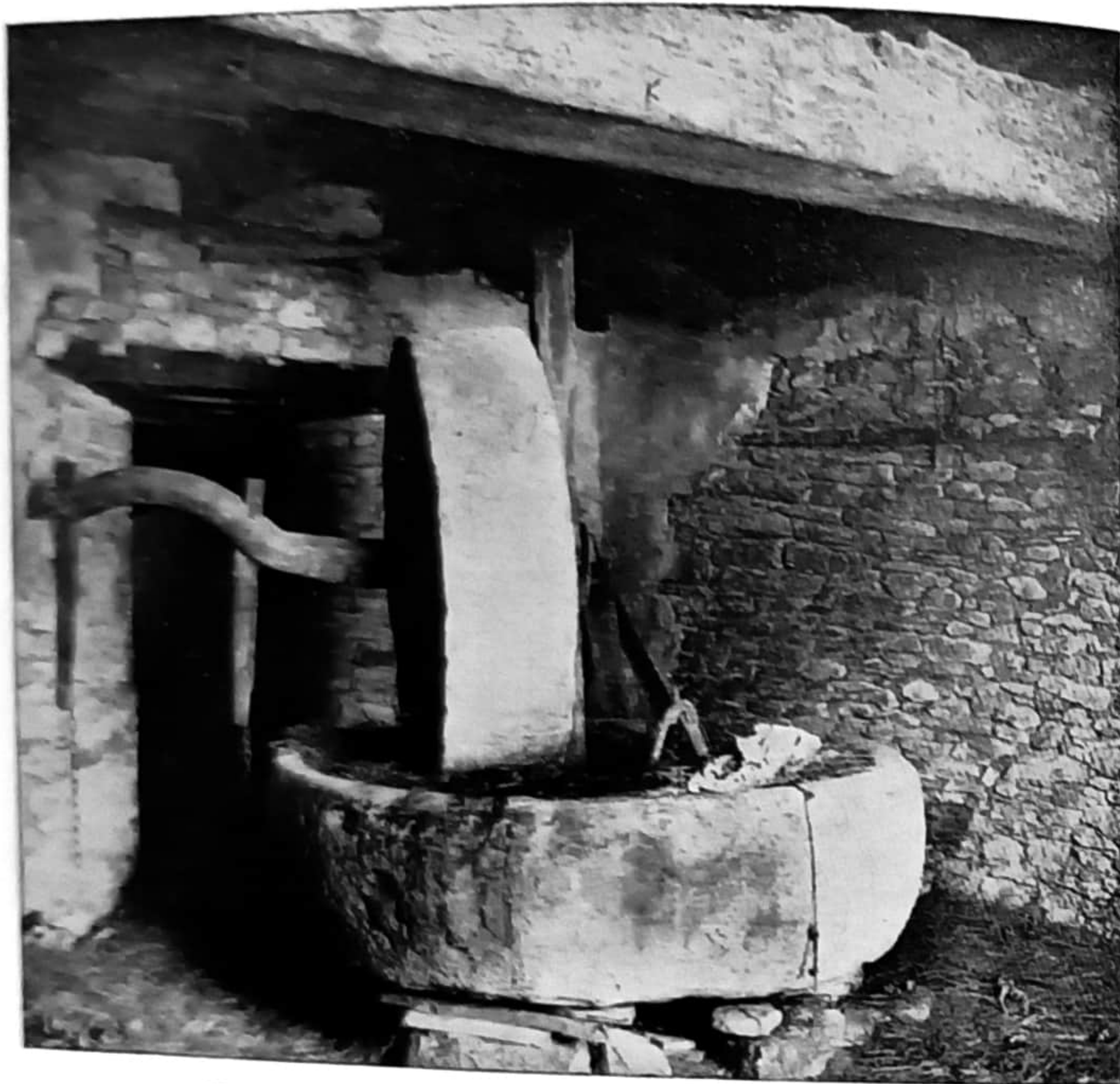
PRESSOIR POUR L'HUILE DE NOIX A MAXOU (DÉTRUIT)
