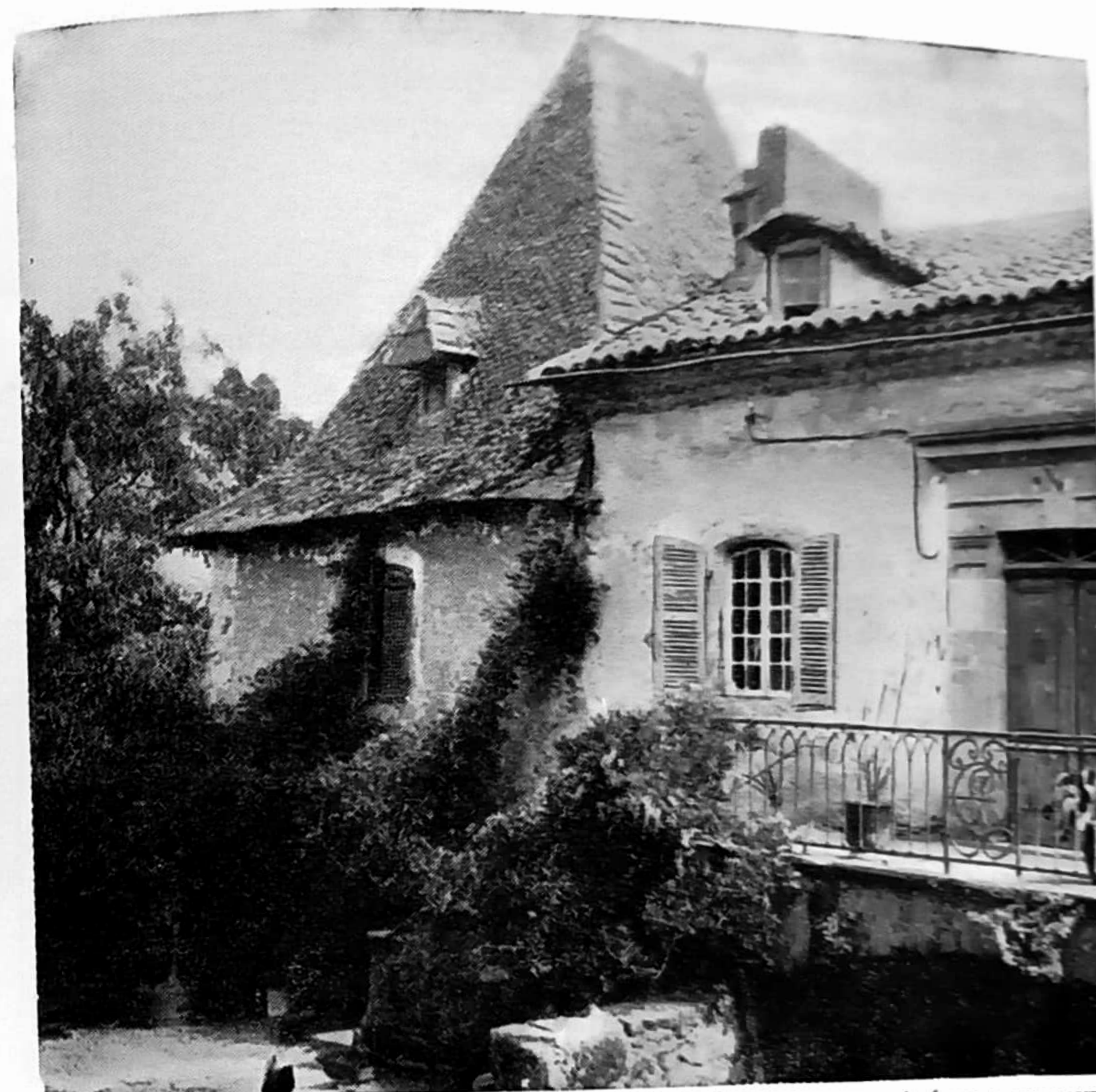
MAISON MIXTE A PORT-D'AGRÈS - TOIT D'ARDOISES DE PAYS DU CÔTÉ DU ROUERGUE TOIT MÉDITERRANÉEN CÔTÉ QUERCY DATÉE DE 1848
