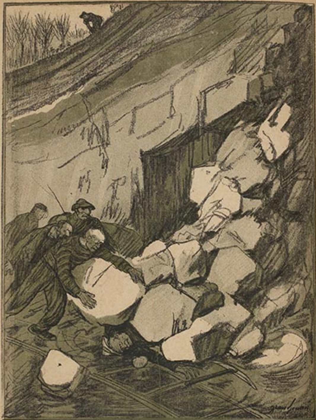
LES CARRIERS. — Détachent au pic et à la « barra à mine » les blocs de pierre des carrières. Parfois les blocs se détachent seuls, écrasant le carrier. Gagnent, aux environs de Paris, 42 centimes 5 par heure de travail et se font, en hiver, des journées de 3 francs 20.
