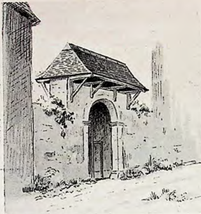
3 VARIANTES DU PORCHE BÉARNAIS . Le premier est soutenu simplement par sa charpente à 1 console ou potence, reposant directement sur le mur de clôture ; le 2 e couronnant le pan de mur plus élevé, encadrant le Porche ; le 3 e également à encadrement saillant au-dessus du mur, soutenu par deux consoles d'extrémité et par deux traverses intermédiaires.
