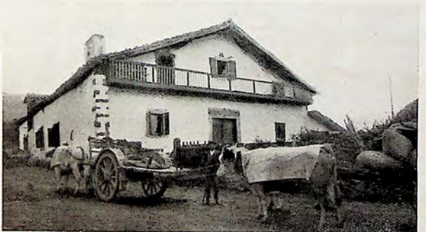
MAISON DE 1745, de la Basse-Navarre, autre exemple typique des agencements de cette région. Le mur de gauche, prolongé, soutient la toiture sous laquelle court un balcon.
