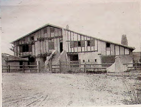
FERME D'HAICABIA. Ce bâtiment est assez curieux d'esprit avec sa partie centrale en retrait desservie à l'étage par un massif escalier extérieur, ce qui est assez rare.
