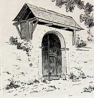
3 VARIANTES DU PORCHE BÉARNAIS . Le premier est soutenu simplement par sa charpente à 1 console ou potence, reposant directement sur le mur de clôture ; le 2 e couronnant le pan de mur plus élevé, encadrant le Porche ; le 3 e également à encadrement saillant au-dessus du mur, soutenu par deux consoles d'extrémité et par deux traverses intermédiaires.
