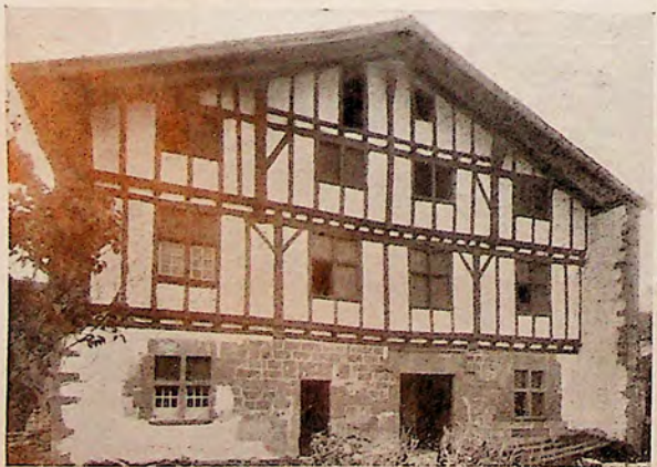
MAISON A OSSÈS. 1. Maison du Chevalier de Malte, type de grande Demeure noble, en pan de bois au-dessus du rez-de-chaussée à trois étages, dont deux à léger encorbellement dans les sablières maintenues par des consoles à larges fenêtres à meneaux. 2. Maison de 1839, à un étage, à pan de bois, et au vaste toit maintenu d'un côté, à gauche, par un mur-gouttereau, et au centre par des potences.
