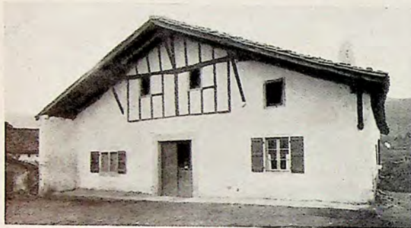
TYPE DE PETITE MAISON rurale à Ossès, montrant, à gauche, le prolongement du grand mur latéral (mur-gouttereau) et à droite l'importante potence soutenant le vaste toit.
