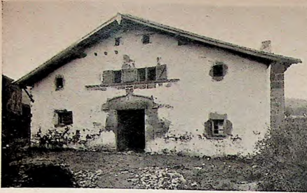
MAISON DATÉE DE 1635, au toit soutenu par le prolongement du mur latéral à droite et par des potences à gauche. Les doubles fenêtres sont en grès rose (à Ossès).
