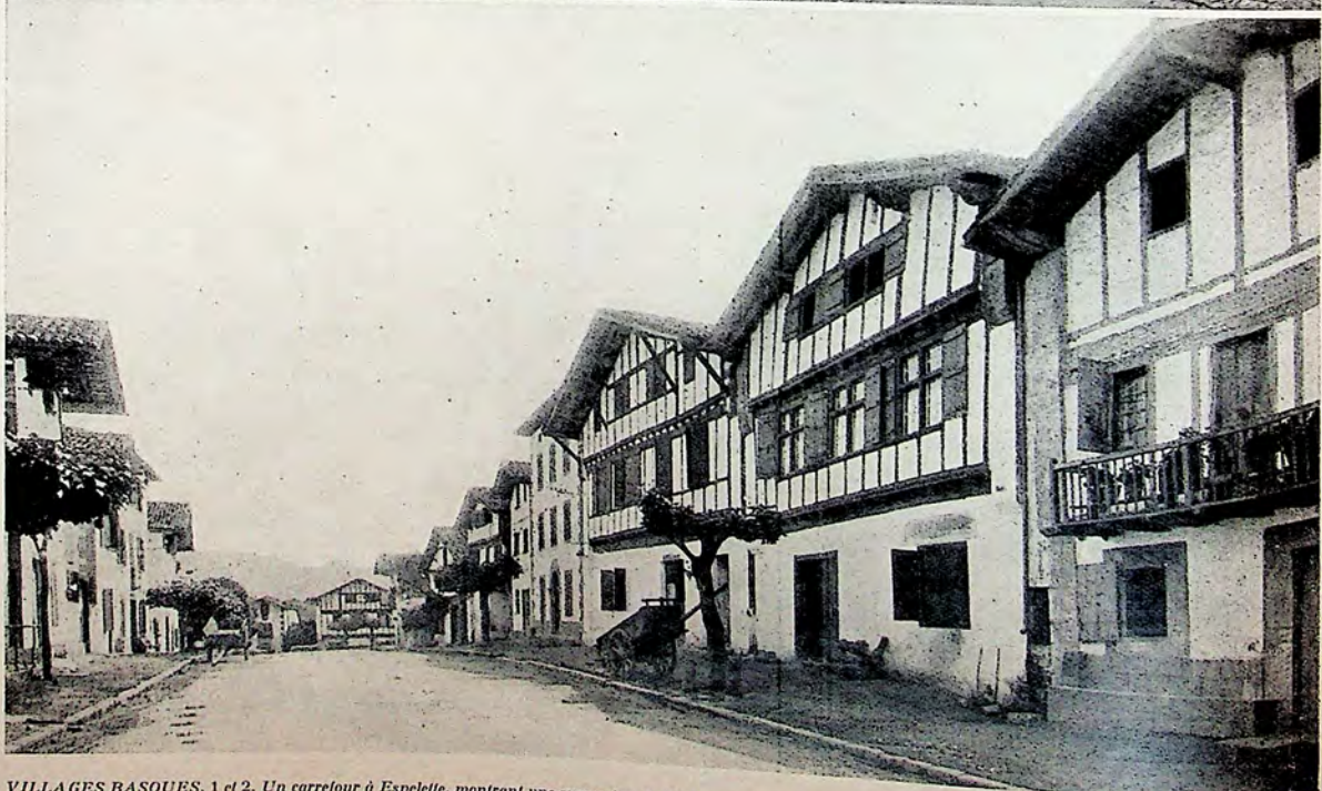
VILLAGES BASQUES . 1 et 2. Un carrefour à Espelette, montrant une succession de Maisons coiffées d'un toit à 4 pentes et d'autres à pignon, avec rebord du toit débordant. A droite : « La Casa », construite en 1810, et appartenant au chanoine T. rana'z. 3. La grande rue d'Ainhoa, joli Village situé dans un cadre de montagnes, sur les confins du Labourd et de la Basse-Navarre, un de ceux conservés intégralement et le plus typiquement dans son caractère Basque. La plupart des Maisons présentent une façade à double encorbellement, et à double solive, des murs latéraux (murs gouttereux).
