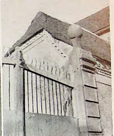
CORNICHES TYPIQUES D'ORTHEZ. 1 et 3. Types de corniches simplement constituées par une rangée de tuiles canal, disposées en bout dans un des deux sens. 2. Modèle assez rare de corniche à double disposition: deux rangées en deux sens, dont une inversée de tuiles-canal, ou tuiles romaines, avec une rangée intérieure de modillons.
