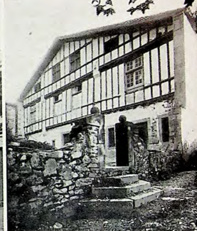
MAISONS DU LABOURD. 1. Irigonia, ancienne ferme, située en plein Labourd, bien que construite sur le même principe que celle de la Basse-Navarre. Le mur en saillie est supporté par le prolongement du mur latéral, à droite, et par la saillie d'une partie du bâtiment à gauche. 3. La Ferme Chapelina, à Saint-Pée, construction à façade amusante, coiffée d'un toit à deux pentes, soutenu par de fines potences. 3. Integaraya, variante du type de Maison du Labourd sans pan de bois.
