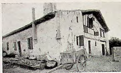
MAISONS DU LABOURD. 1. Irigonia, ancienne ferme, située en plein Labourd, bien que construite sur le même principe que celle de la Basse-Navarre. Le mur en saillie est supporté par le prolongement du mur latéral, à droite, et par la saillie d'une partie du bâtiment à gauche. 3. La Ferme Chapelina, à Saint-Pée, construction à façade amusante, coiffée d'un toit à deux pentes, soutenu par de fines potences. 3. Integaraya, variante du type de Maison du Labourd sans pan de bois.
