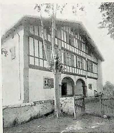
MAISONS DU LABOURD. 1. Irigonia, ancienne ferme, située en plein Labourd, bien que construite sur le même principe que celle de la Basse-Navarre. Le mur en saillie est supporté par le prolongement du mur latéral, à droite, et par la saillie d'une partie du bâtiment à gauche. 3. La Ferme Chapelina, à Saint-Pée, construction à façade amusante, coiffée d'un toit à deux pentes, soutenu par de fines potences. 3. Integaraya, variante du type de Maison du Labourd sans pan de bois.
