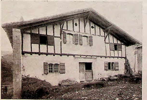
MAISON A OSSÈS. 1. Maison du Chevalier de Malte, type de grande Demeure noble, en pan de bois au-dessus du rez-de-chaussée à trois étages, dont deux à léger encorbellement dans les sablières maintenues par des consoles à larges fenêtres à meneaux. 2. Maison de 1839, à un étage, à pan de bois, et au vaste toit maintenu d'un côté, à gauche, par un mur-gouttereau, et au centre par des potences.
