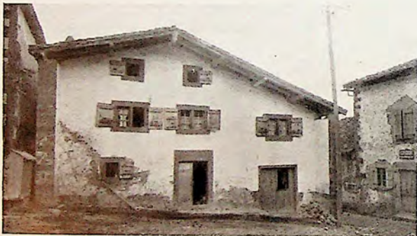
MAISON A SAINT-MARTIN D'AROSSA, à deux panneaux de toit inégaux, modèle très caractéristique de construction de Basse-Navarre, à ostensor et rosaces.
