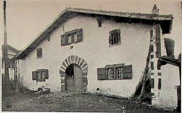
MAISON DATÉE DE 1754 (à Ossès). La porte principale cintrée est flanquée, au rez-de-chaussée, de deux doubles fenêtres; une autre éclairant le grenier le surmonte.
