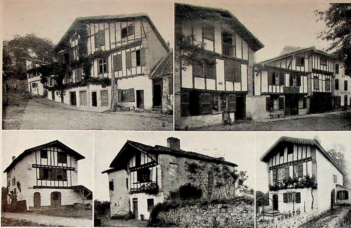
1. QUATRE MAISONS sous le même toit à Ciboure. Les murs extérieurs, très robustes, supportent l'importante toiture. 2. Amusant groupe de Maisons sur la place de l'Eglise, à Saint-Pée. 3. Petite Maison de ferme du Labourd, à Aruns, datée de 1696. 4. Ikalaria-Bélaché, Maison Labourdine à deux étages et à façade très limitée, à Aruns. 5. Presbytère d'Aruns à deux étages, à encorbellement et à pan de bois.
