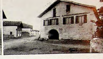
MAISONS DU LABOURD. 1. Irigonia, ancienne ferme, située en plein Labourd, bien que construite sur le même principe que celle de la Basse-Navarre. Le mur en saillie est supporté par le prolongement du mur latéral, à droite, et par la saillie d'une partie du bâtiment à gauche. 3. La Ferme Chapelina, à Saint-Pée, construction à façade amusante, coiffée d'un toit à deux pentes, soutenu par de fines potences. 3. Integaraya, variante du type de Maison du Labourd sans pan de bois.
