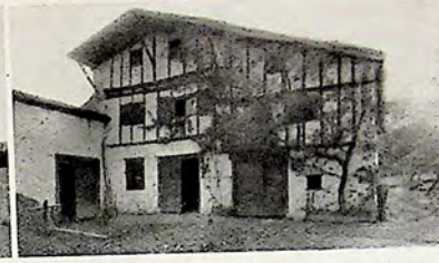
MAISONS DU LABOURD. 1. Irigonia, ancienne ferme, située en plein Labourd, bien que construite sur le même principe que celle de la Basse-Navarre. Le mur en saillie est supporté par le prolongement du mur latéral, à droite, et par la saillie d'une partie du bâtiment à gauche. 3. La Ferme Chapelina, à Saint-Pée, construction à façade amusante, coiffée d'un toit à deux pentes, soutenu par de fines potences. 3. Integaraya, variante du type de Maison du Labourd sans pan de bois.
