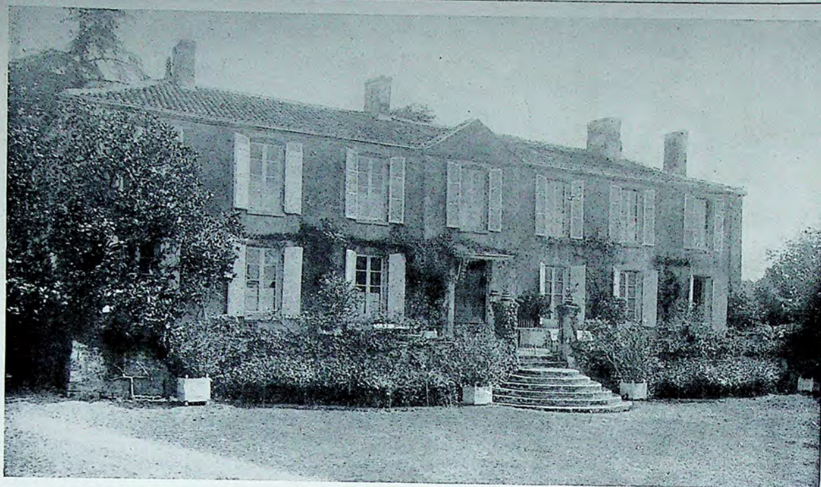
LOGIS DU BEAUREGARD. Cette Demeure très caractéristique, construite avec des matériaux du pays, recouverte de crépi et coiffée d'un toit bas de tuiles au-dessus duquel se découpe l'arête simple du fronton, est infiniment plaisante; à M. Valette.
