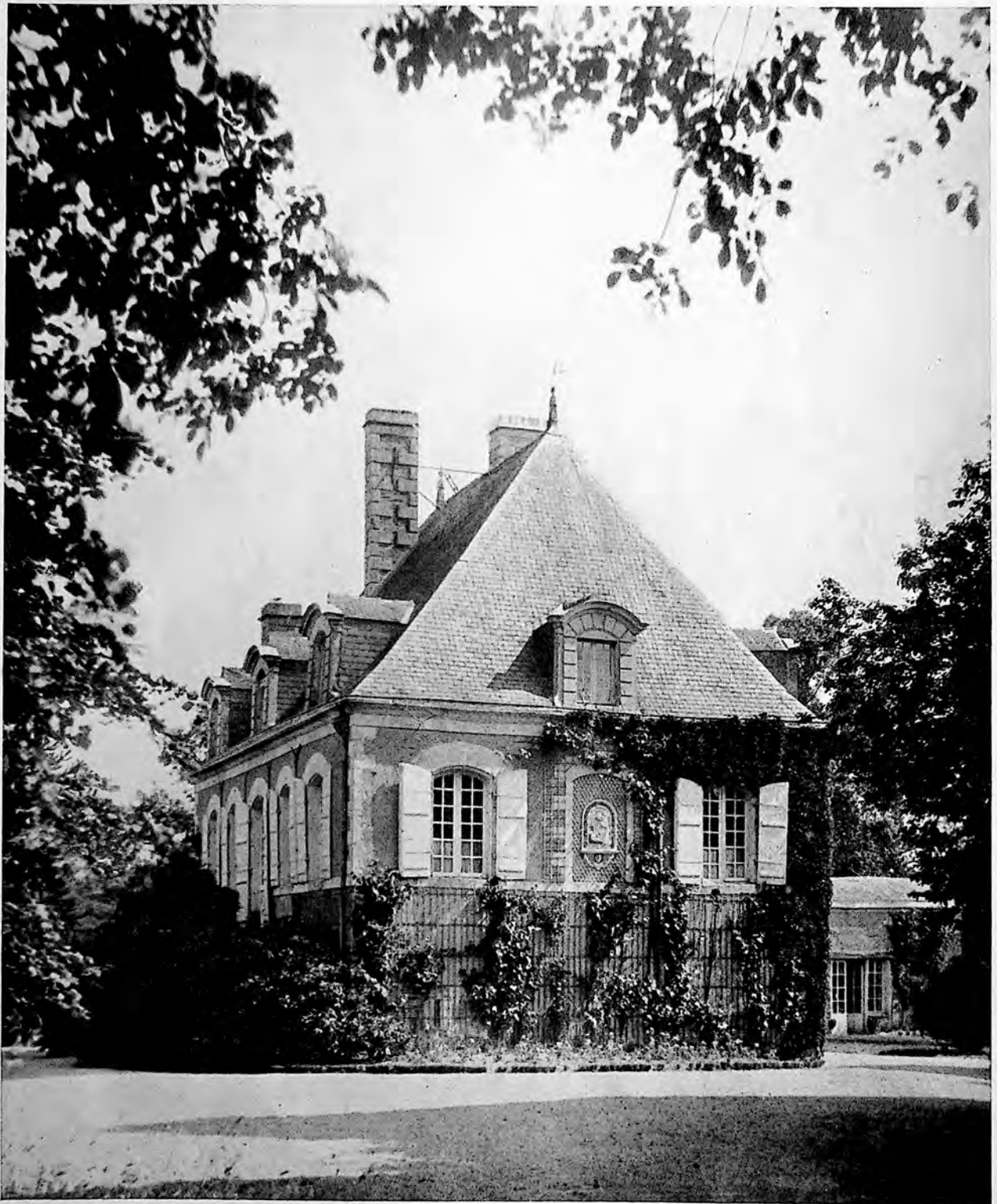
• LES RANJARDIÈRES •. Cet accueillant Logis de silhouette rectiligne, aux façades percées de baies largement encadrées de pierre et à petits carreaux, est couvert d'un toit en ardoise dans lequel se découpent d'importantes lucarnes avec encadrement de pierre. La Vigne vierge de Veitch, aux tonalités vertes et pourprés, ajoute une note plaisante à la gamme colorée des matériaux. Cette charmante Maison fut la demeure de campagne de l'Académicien René Bazin ; à Mme René Bazin.
