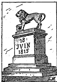
Le Lion de Waterloo : hauteur, 4 m. 50 ; piédestal, 7 mètres.
