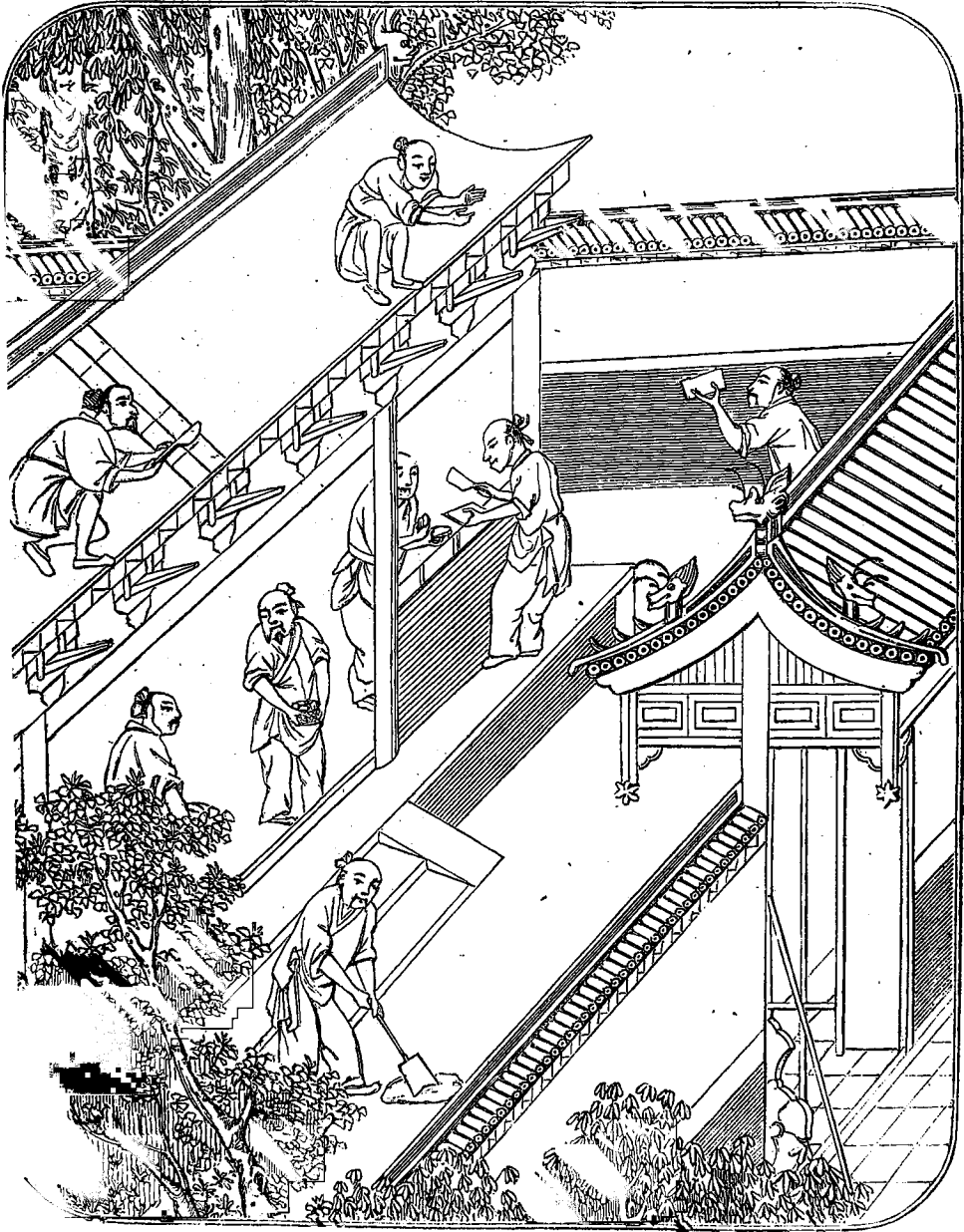
Construction d'une maison chinoise. — D'après une peinture chinoise représentant une scène historique de la dynastie des Tang (618 à 906 avant Jésus-Christ); cabinet des estampes de la Bibliothèque impériale (*).
