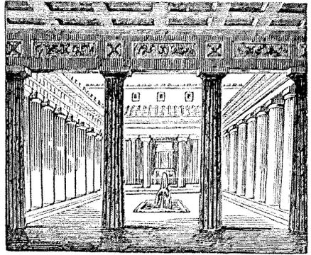
tre côtés d'un *atrium* dans une maison romaine, et vers laquelle ces côtés convergeaient pour faire descendre la pluie dans un réservoir (*impluvium*), creusé dans le plancher immédiatement au-dessous, comme on le voit clairement par la gravure, qui représente l'intérieur d'un atrium de Pompéi restauré (Varro, *L. L.* v, 161; Festus, *v.* *Impluvium*; Vitruv. VI, 3, 6). Dans un passage de Suétone (*Aug.* 92), tout l'espace découvert, *area*, entouré par la colonnade, est appelé *compluvium*.
