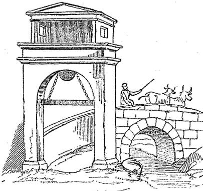
de telle façon qu'on pouvait l'abaisser et la lever par des anneaux et des chaînes de fer à volonté (Liv. XXVII, 28; Veget. *Mil.* IV, 4). Dans une des anciennes portes qui subsistent encore à Rome, dans une autre à Tivoli et aussi à Pompéi, on voit distinctement les coulisses dans lesquelles jouait la herse; et le spécimen donné ici d'après une ancienne fresque,
