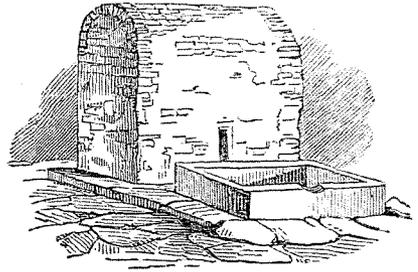
due pour la commodité du voisinage (Vitruv. VIII, 6, 1). Il diffère de la *cisterna*, qui était au-dessous du sol, et on en a un spécimen dans la gravure ci-jointe, prise d'un modèle à Pompéi. Le haut bâtiment voûté est le réservoir, d'où l'eau coulait par la petite ouverture sombre du bas dans l'auge de pierre carrée (*immissarium*) au niveau du pavé. La ville de Pompéi renferme plusieurs autres bassins de ce genre.
