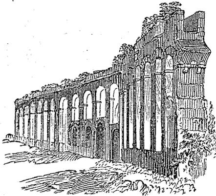
*Aquæduct.*). La figure représente une partie de l'aqueduc construit par l'empereur Claude : il est bâti de travertin et n'a qu'un rang d'arches; mais certains aqueducs portaient trois cours d'eau séparés dans des canaux distincts, l'un au-dessus de l'autre; et d'autres avaient deux ou trois rangs d'arches, suivant la nature du pays qu'ils traversaient. On voit le canal (*specus*) par lequel l'eau passait : il est découvert au sommet.
